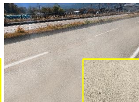
写真-2 コンクリート舗装
