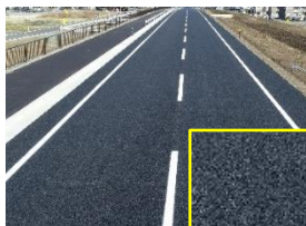
写真-1 アスファルト舗装
