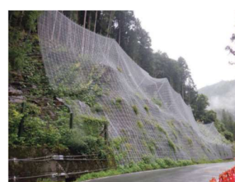
強靱防護網の施工例
