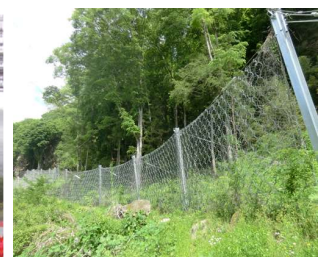
マクロフェンスの施工例
