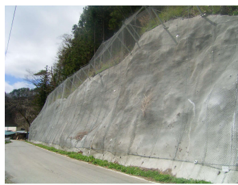
ポケット式落石防護網工の例
