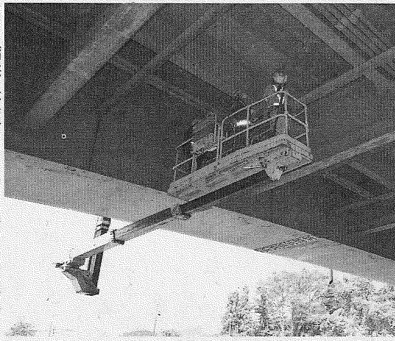
橋梁点検車からひび割れなどを確認
