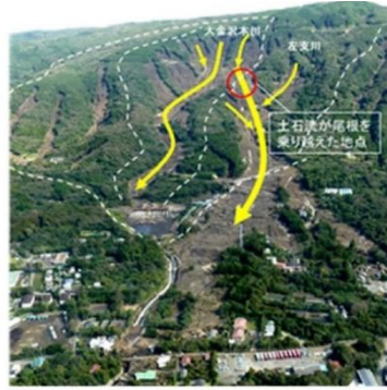
平成25年に伊豆大島で発生した土石流の状況
