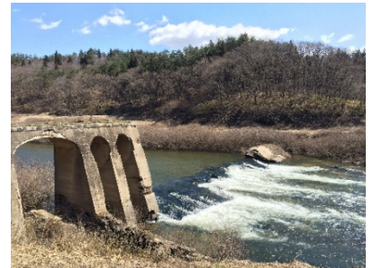
▲画像①：堰堤・取水口跡
