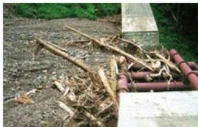
写真3 流木を捕捉した透過型砂防堰堤
