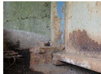
写真-2 A1 橋台上 G3 支承 (可動) 腐食
