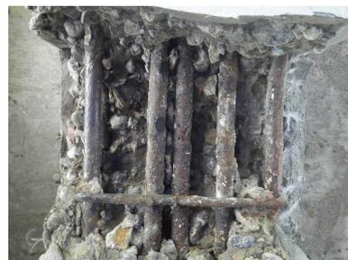
写真-2 G1 桁鉄筋径の減少
