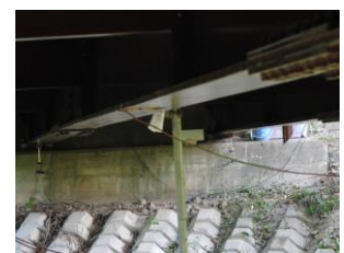
写真-2 ターゲット設置状況
