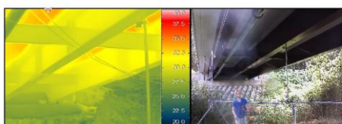
写真-7 赤外線サーモグラフィー画像 (8月8日 14:00)
