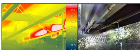
写真-8 赤外線サーモグラフィー画像 (8月8日 17:00)
