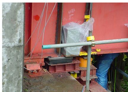
写真-4 梨の木橋 仮設ゴム支承設置状況
