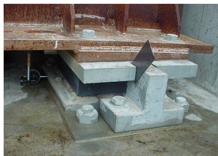
写真-1 落合橋 固定支承の拘束状況
