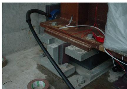
写真-2 落合橋 可動支承の拘束状況
