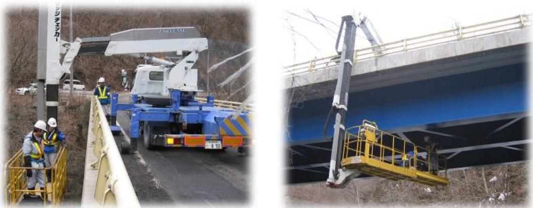
写真-1 橋梁点検車を利用した調査事例 国道 281 号
